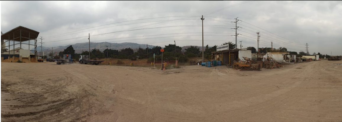
Fotografía 3. Panorámica de locación proyectada para la Planta de Trituración de RCD – Vista 2
